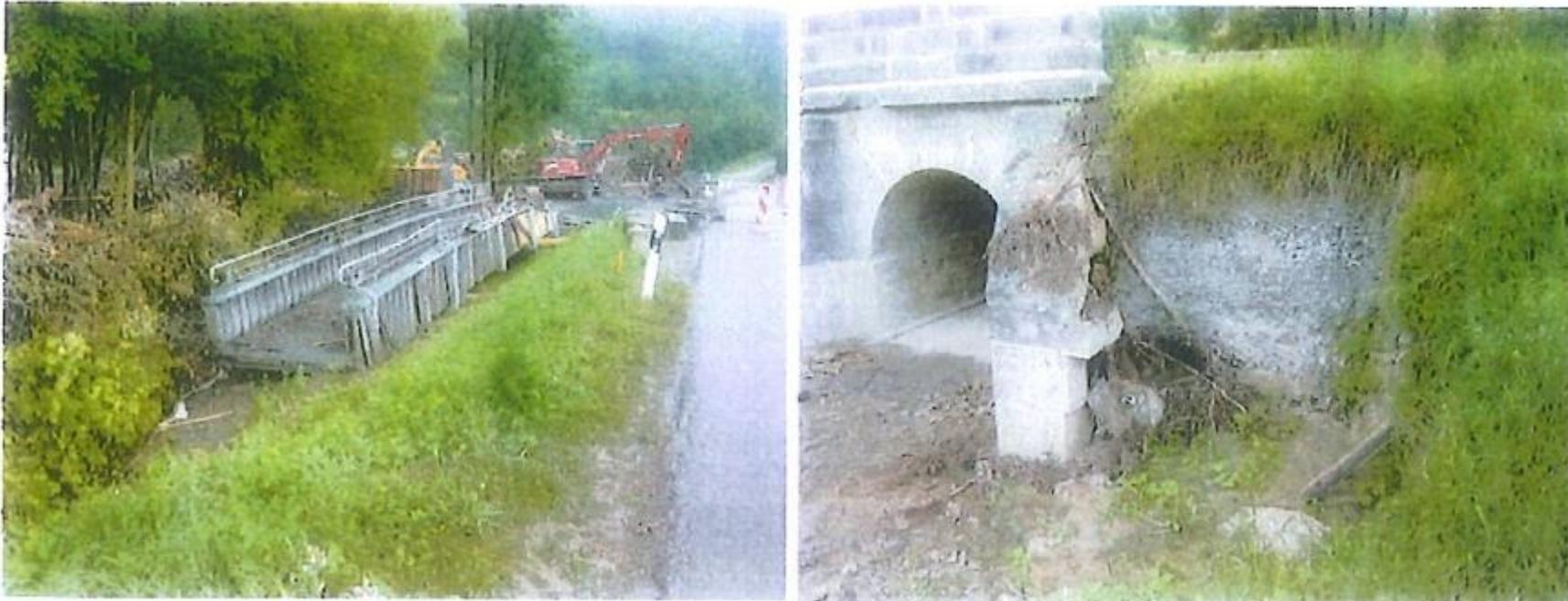
**Abb.1: zerstörte Trogbrücke**
